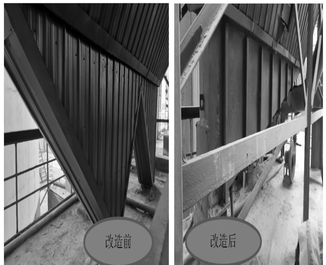
图4 灰斗改造前 图5 灰斗改造后
